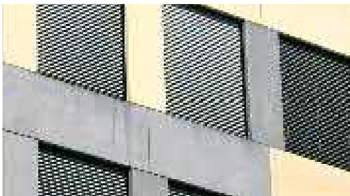
Lamellenstoren können das Tageslicht nicht nur dosieren, sondern durch Schrägstellen der Lamellen bis zu einem gewissen Grad auch lenken.
