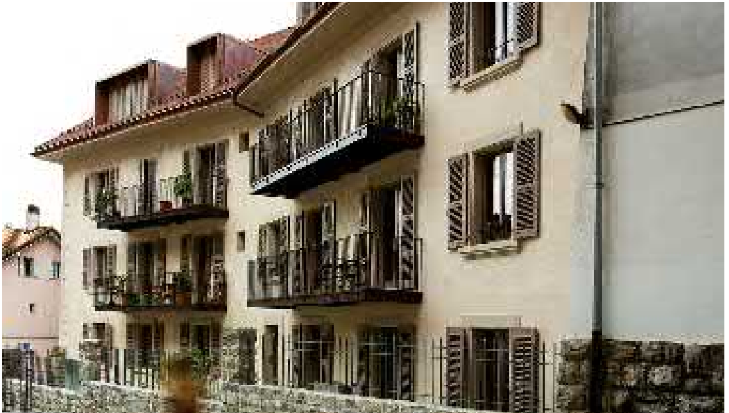
Bei diesem sanierten Gebäude in Lausanne sind die Balkone thermisch vom Gebäude getrennt und erzeugen so keine Wärmeverluste. Foto: Thomas Hensinger
