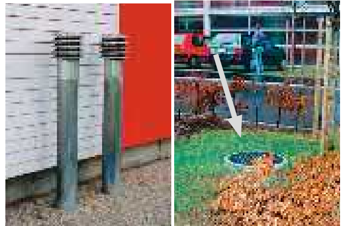
Ein gutes (links) und ein schlechtes Beispiel (rechts) für eine Aussenluftfassung. Ist die Fassung ebenerdig angebracht, können Staub, Blätter und andere Immissionen die Anlage verschmutzen.
