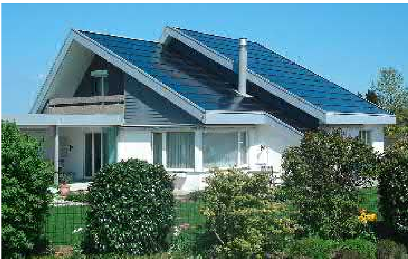
Bei der Sanierung des Einfamilienhauses in Giebenach wurde die Ölheizung durch eine Wärmepumpe ersetzt. Einen Teil des benötigten Stroms produziert neu eine vollflächige, dachintegrierte Photovoltaikanlage. Quelle: EnergieSchweiz
