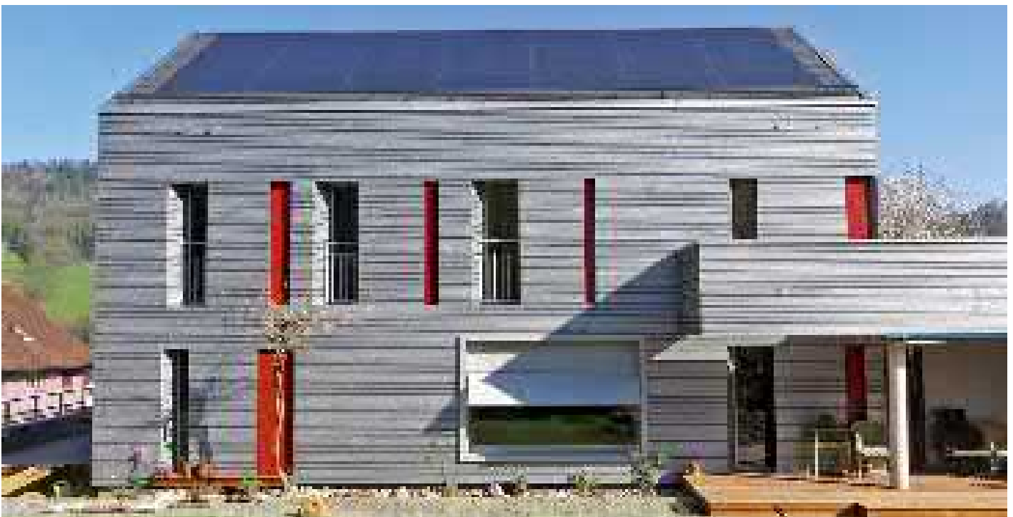
Eine umfassende Sanierung wie bei diesem Einfamilienhaus in Malter ist in der Regel nach 40 bis 50 Jahren nötig. Quelle: EnergieSchweiz
